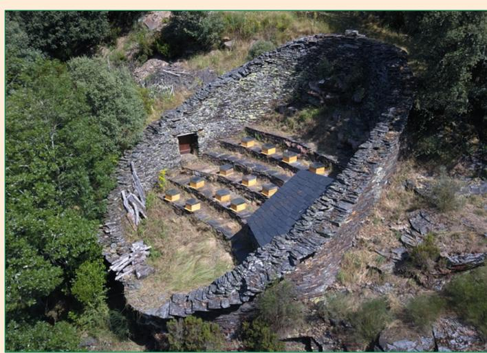
A maior parte dos alvares que atopamos na ruta caracterízanse por ser estruturas de planta circular, con muros de aproximadamente dous metros de altura e uns 70 cm de grosor rematados por un beiril de grandes pedras planas, chamadas bardos. A altura dos muros e a presenza dos bardos, explícanse pola protección que se quería dar ás colmeas fronte á súa maior ameaza naqueles momentos: o oso pardo.
